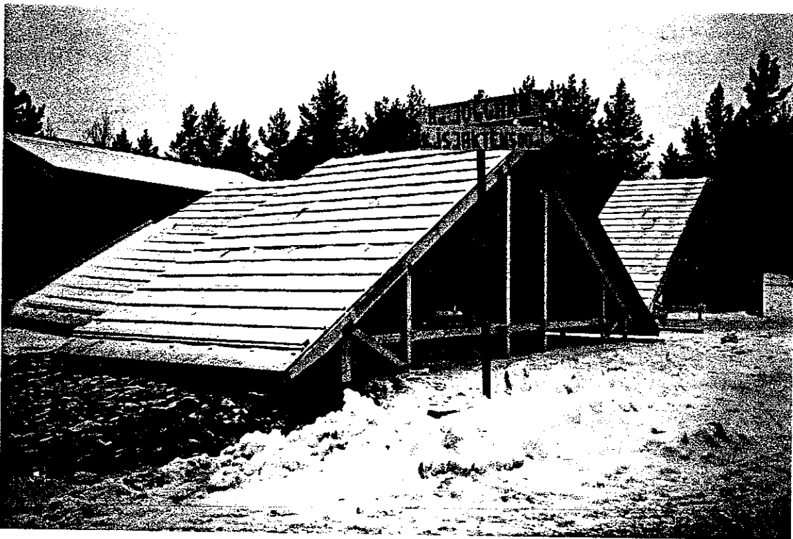
Fig 5.6.2.2 Förtillverkade taksektioner inom Kv Joggaren.
